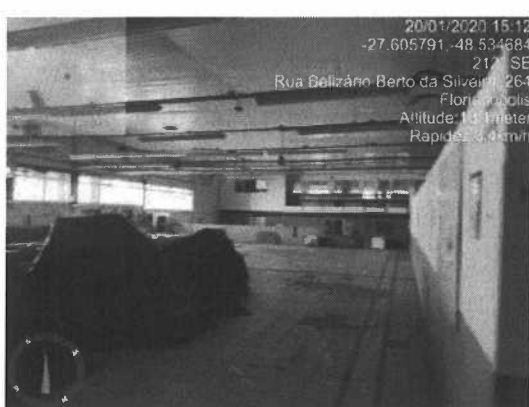
Figura 25 – Vista interna do galpão.
