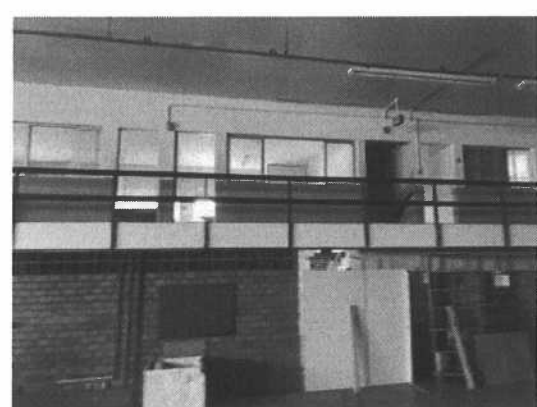
Figura 26 – Vista interna do galpão – parte administrativa.
