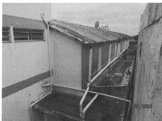
Figura 37 – Vista lateral do galpão.
