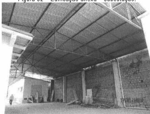
Figura 34 – Edificação anexa – cobertura metálica.
