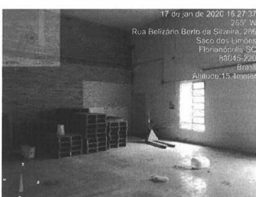
Figura 27 – Vista interna do galpão.
