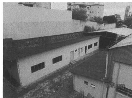
Figura 38 – Vista superior (coberturas).
