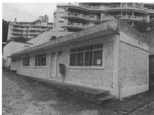
Figura 31 – Edificação anexa – laboratório.
