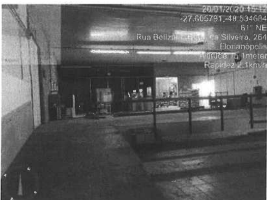
Figura 24 – Vista interna do galpão.
