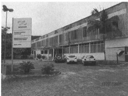
Figura 01 – Vista frontal do imóvel avaliando.
