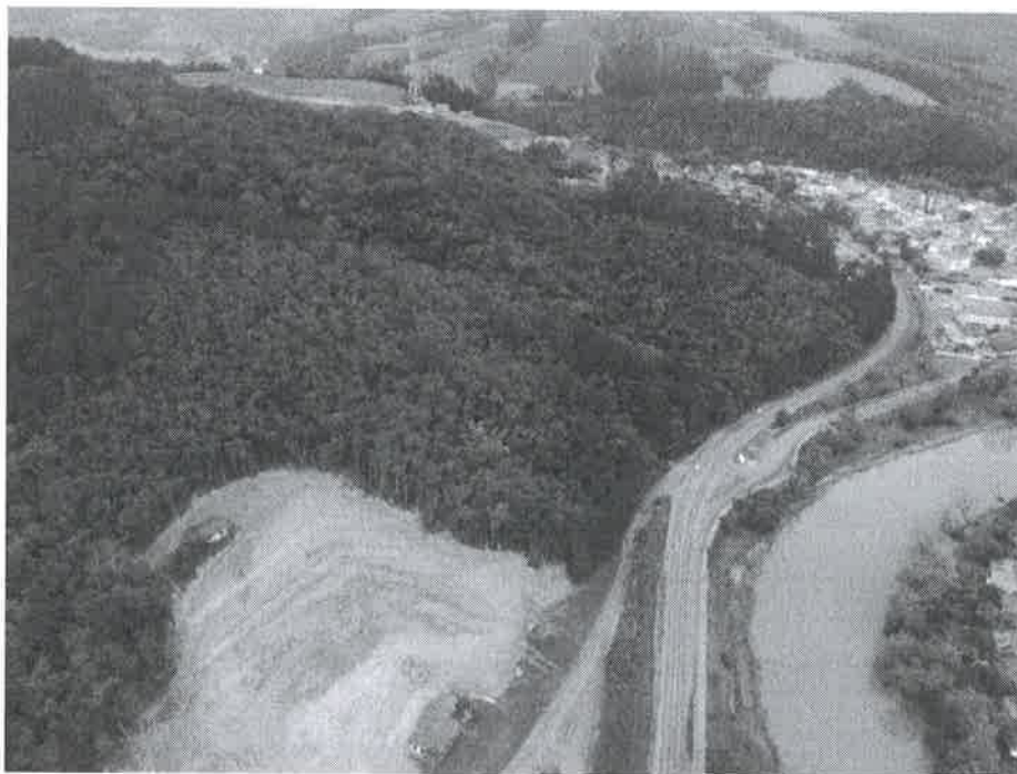
Imagem 1 – Vista aérea do imóvel desde a SC-350.
