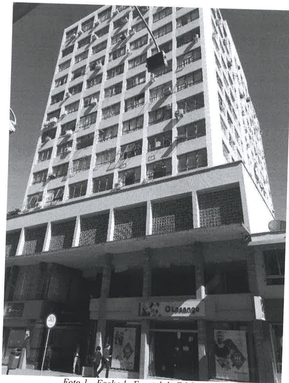
Foto 1 - Fachada Frontal do Edifício.
