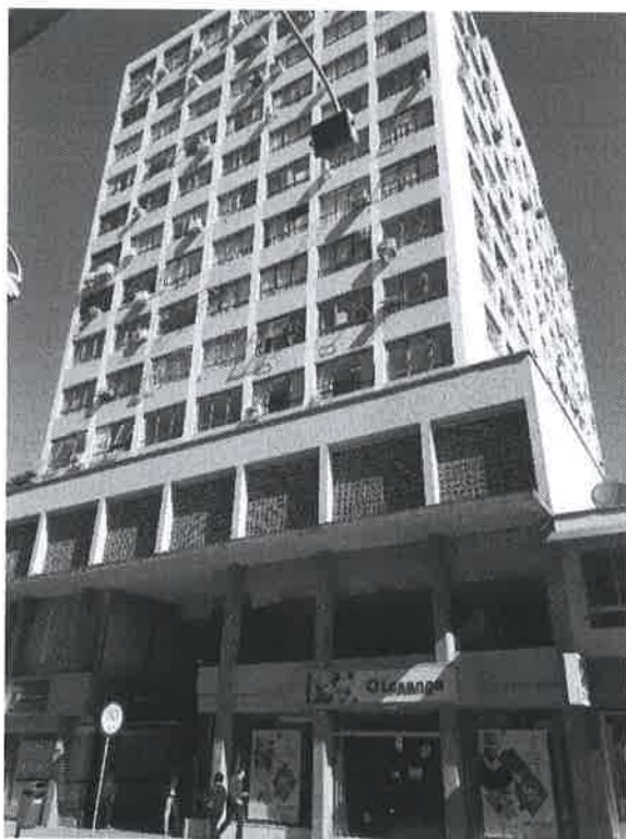
Foto 1 - Fachada Frontal do Edifício.
