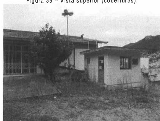
Figura 40 – Guarita – acesso terreno anexo.
