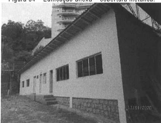
Figura 36 – Edificação anexa - refeitório.
