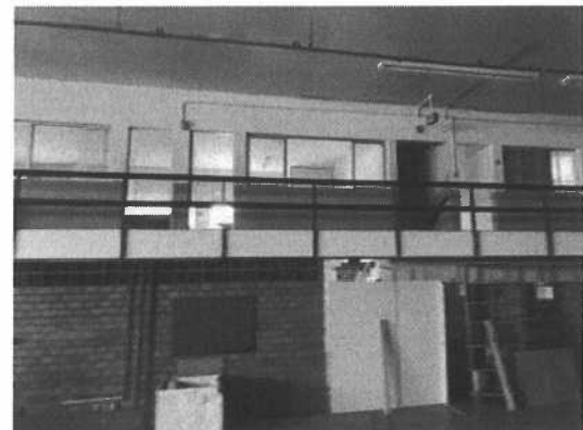
Figura 26 – Vista interna do galpão – parte administrativa.
