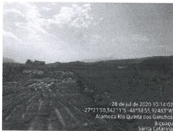
Figura 03 – Vista geral do terreno.
