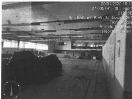
Figura 25 – Vista interna do galpão.
