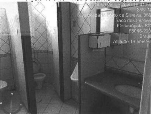
Figura 47 – Banheiro do segundo pavimento.
