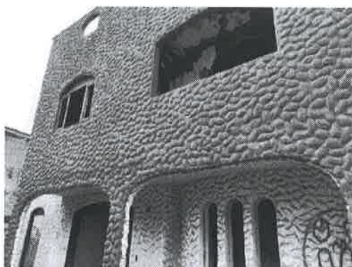
Foto 04 – Vista do andar superior
