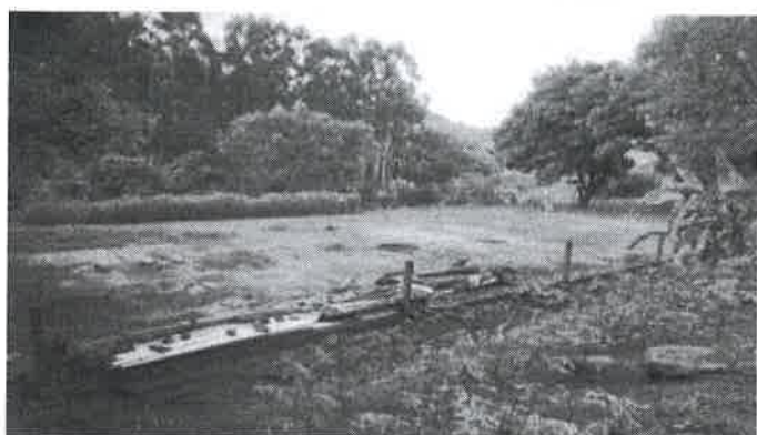
Foto 05: Quadra de esportes deteriorada
