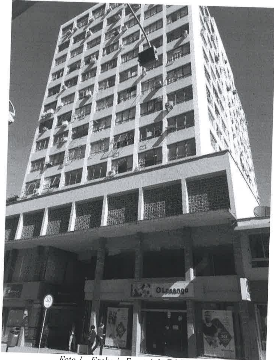
Foto 1 - Fachada Frontal do Edifício.
