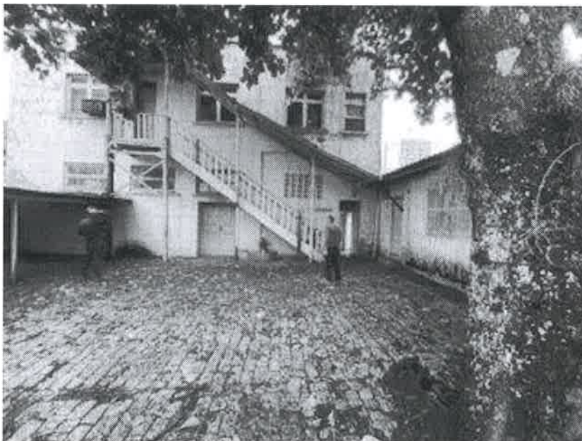
Vista interna do imóvel avaliando
