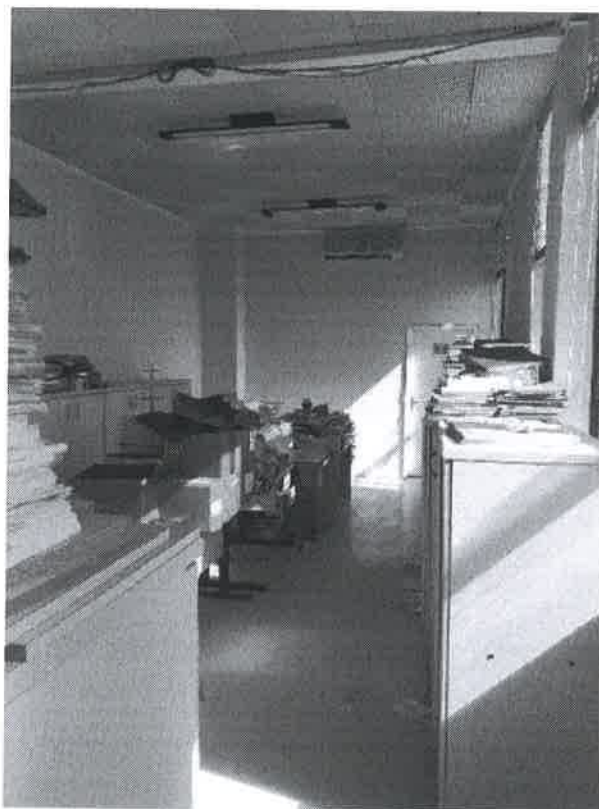
Foto 4 - Vista interna de sala, anteriormente ocupada pela GERED.
