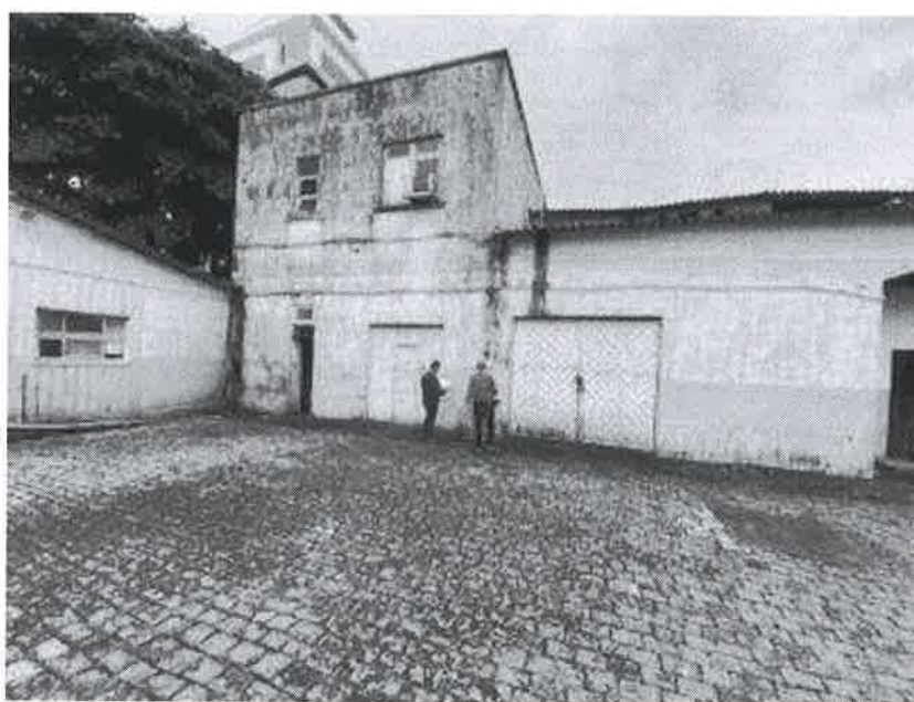
Vista interna do imóvel avaliando
