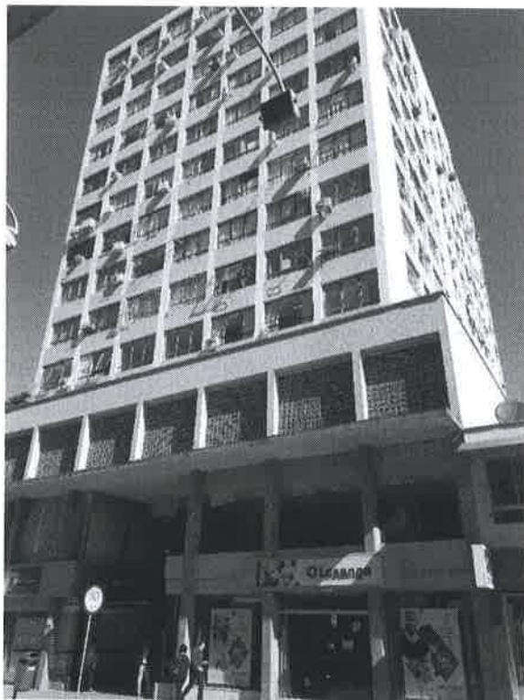
Foto 1 - Fachada Frontal do Edifício.
