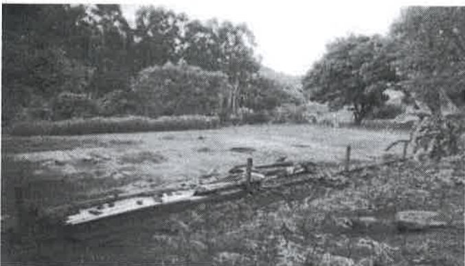
Foto 05: Quadra de esportes deteriorada
