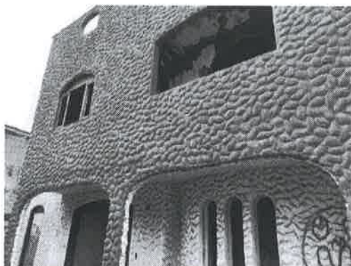
Foto 04 – Vista do andar superior
