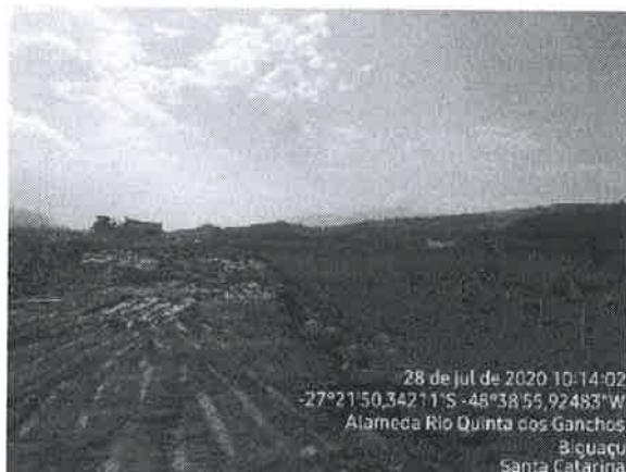
Figura 03 – Vista geral do terreno.
