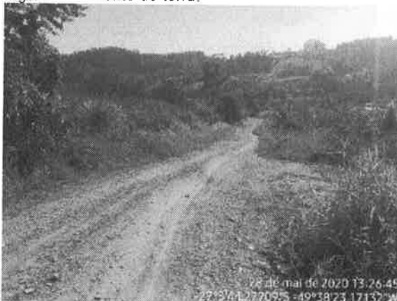
Figura 09 – Vista geral da parte alta do terreno.
