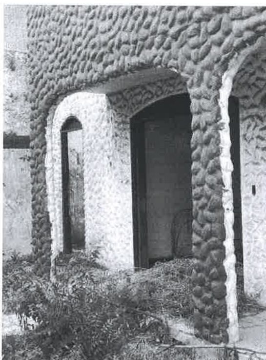
Foto 03 – Acesso ao interior da edificação
