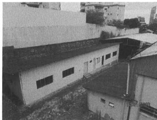
Figura 38 – Vista superior (coberturas).
