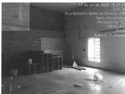
Figura 27 – Vista interna do galpão.
