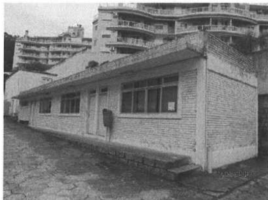
Figura 31 – Edificação anexa – laboratório.
