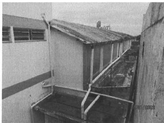
Figura 37 – Vista lateral do galpão.
