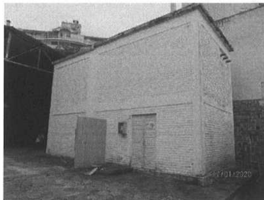
Figura 32 – Edificação anexa – subestação.
