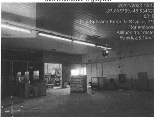
Figura 23 – Vista interna do galpão.
