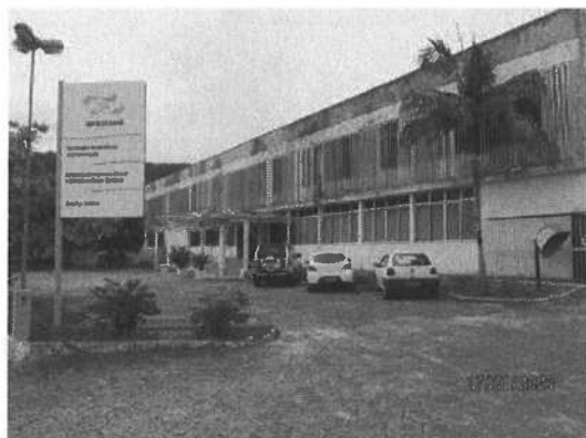
Figura 01 – Vista frontal do imóvel avaliando.
