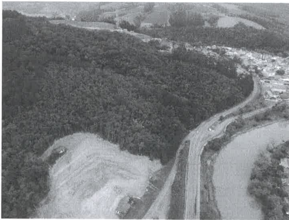
Imagem 1 – Vista aérea do imóvel desde a SC-350.
