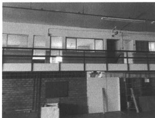
Figura 26 – Vista interna do galpão – parte administrativa.
