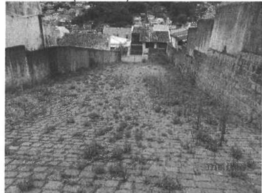
Figura 52 – Acesso lateral – imóvel da matrícula nº 140.
