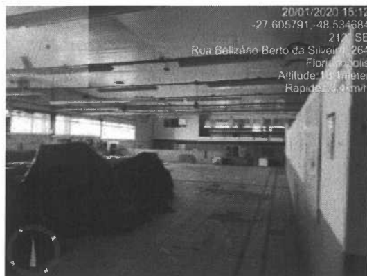
Figura 25 – Vista interna do galpão.
